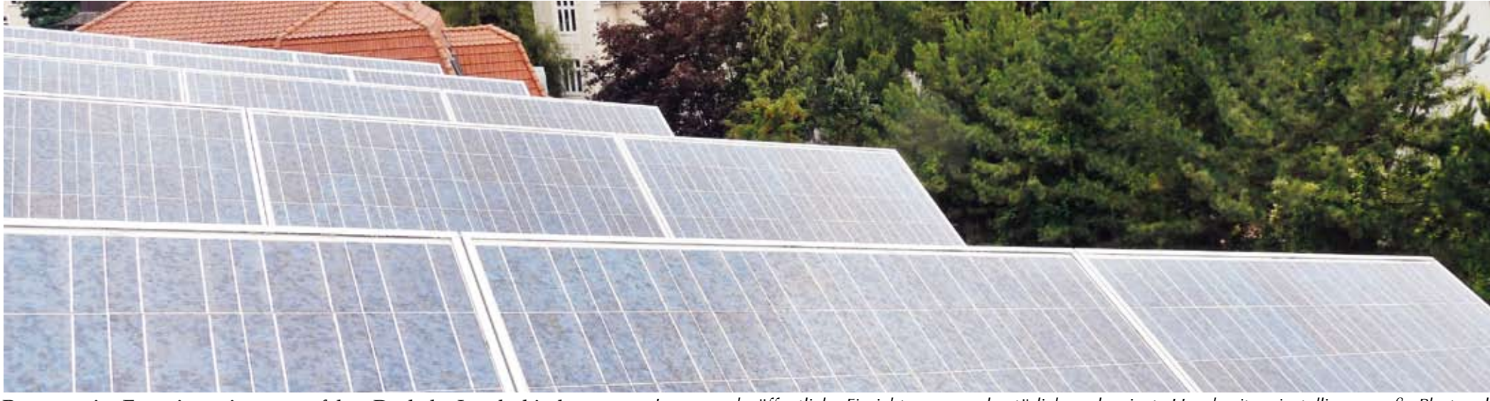
Regenerative Energiegewinnung auf dem Dach des Landeskirchenamtes: Immer mehr öffentliche Einrichtungen und natürlich auch private Hausbesitzer installieren große Photovoltaikanlagen auf ihren Hausdächern und nutzen damit die Sonne als kostenlosen Energielieferanten.
